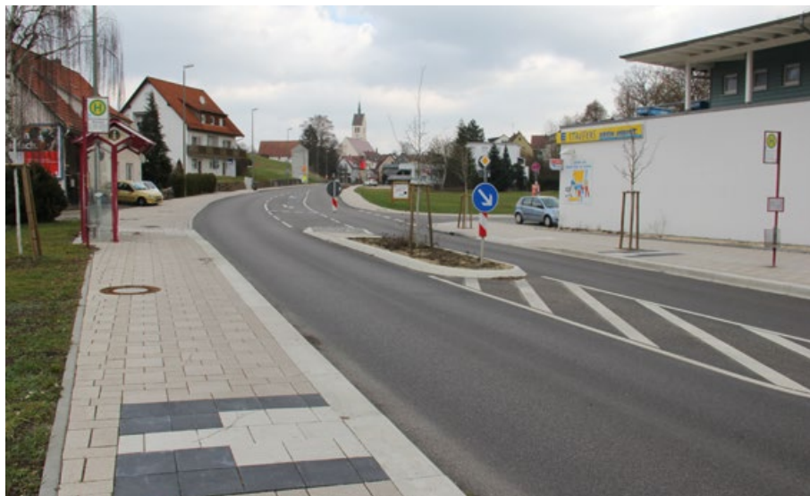
Bushaltestelle mit Bus-Kaps, Warte- bäuschen und Blindenleiteinrichtung
