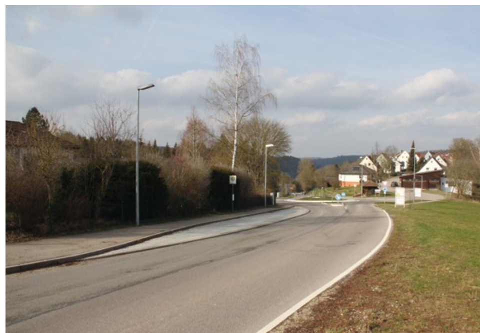
Fahrbahnmarkierung am unbefestigten Fahrbahnrand
