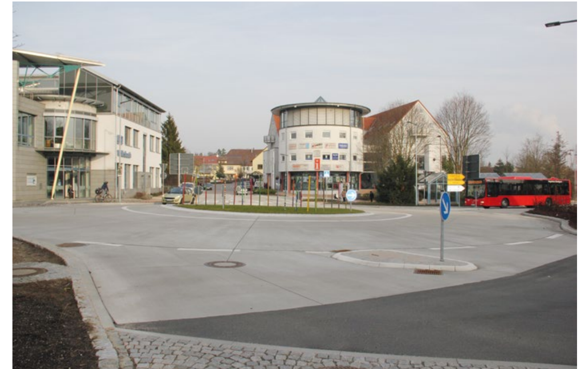
Betonierter Kreisverkehr
