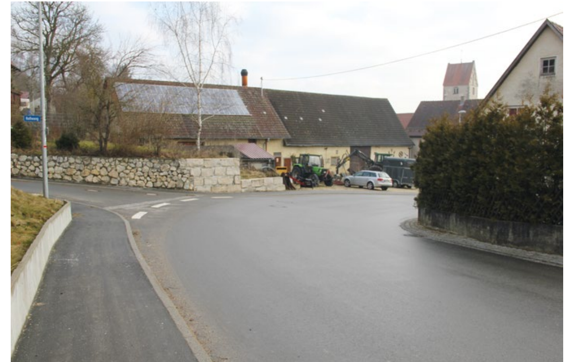
Fahrbahnmarkierung nur im Einmündungsbereich
