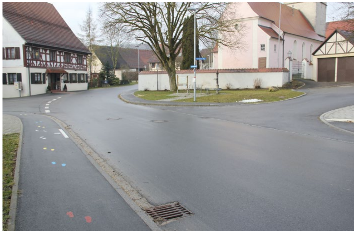
Fahrbahnmarkierung nur im Einmündungsbereich
