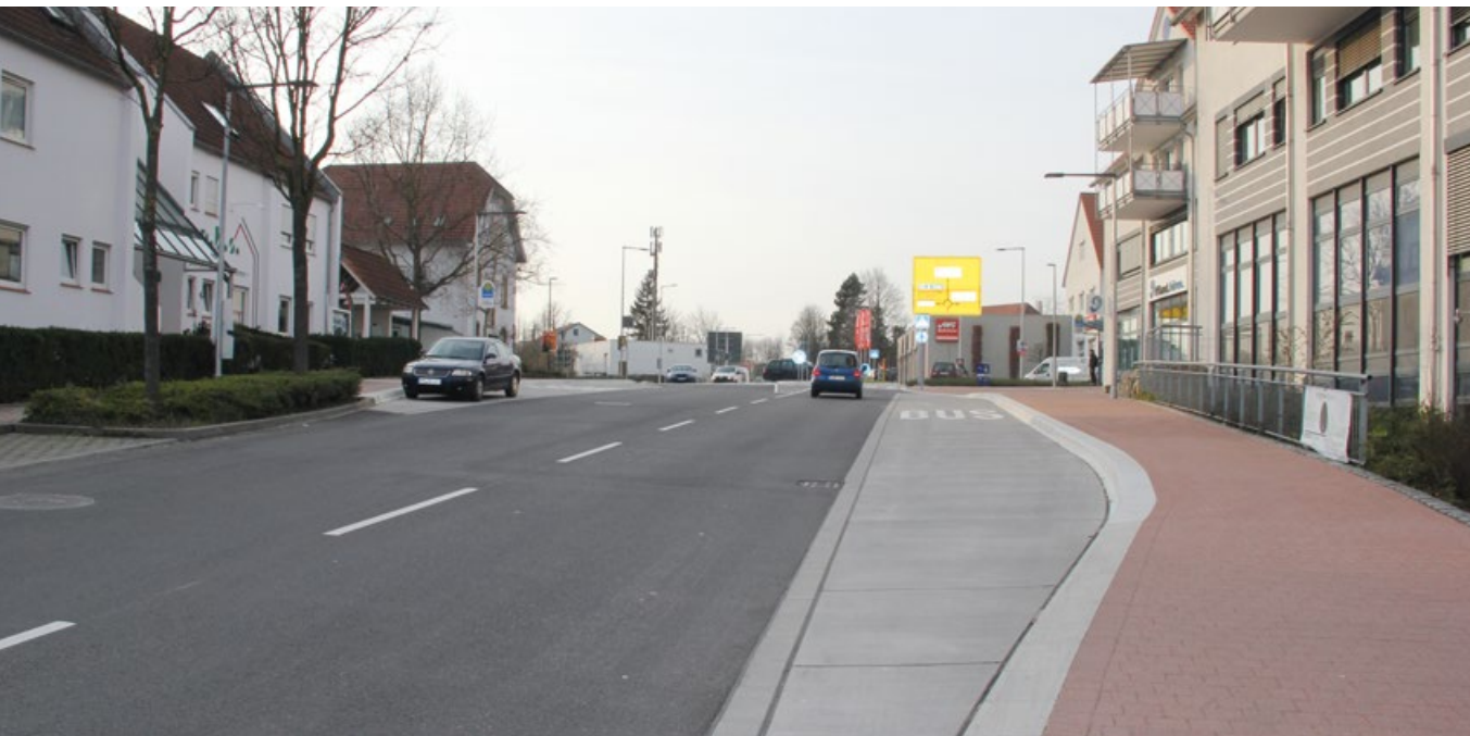
Brackenbeim, betonierte Busbucht
