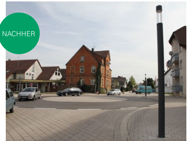
Mini-Kreisverkehr mit überfahrbarer Mittelinsel
