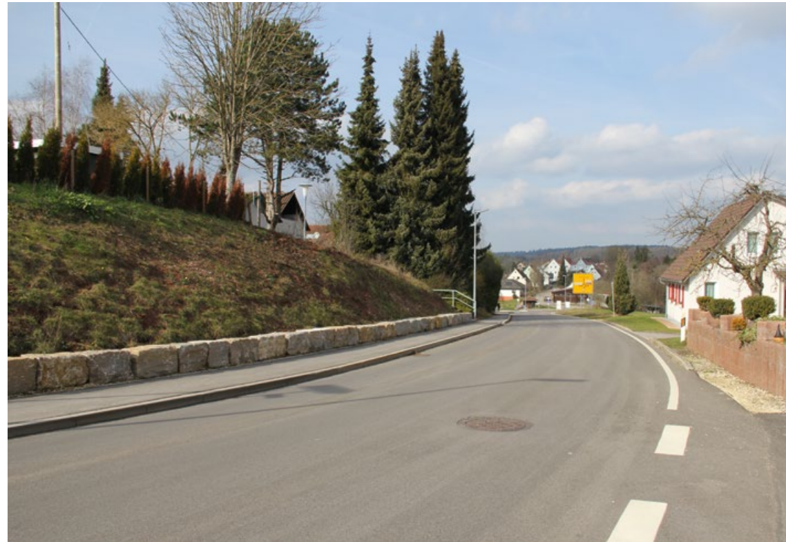
Einreihige Natursteinmauer und Fahrbahnmarkierung am unbefestigten Fahrbahnrand
