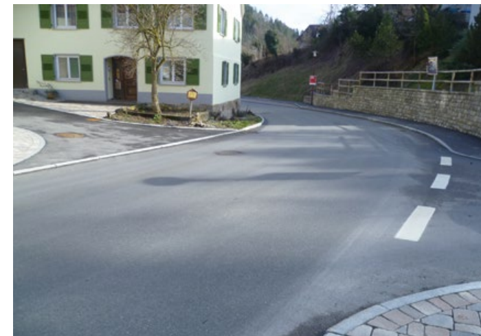
Stützmauer aus Naturstein
