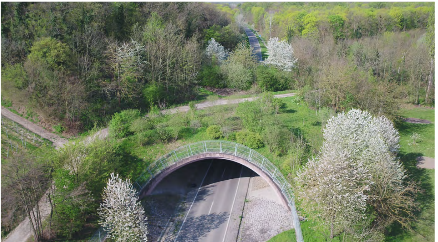
Abbildung 7: Blick auf die Grünbrücke Sasbach von Osten. Gut ist der auf die Kappen gesetzte Zaun zu erkennen. Mit der Maßnahme konnte eine deutliche Verbreiterung der nutzbaren Breite der Grünbrücke erreicht und damit die Funktionalität optimiert werden. Datum der Aufnahme: 08.04.2020.
