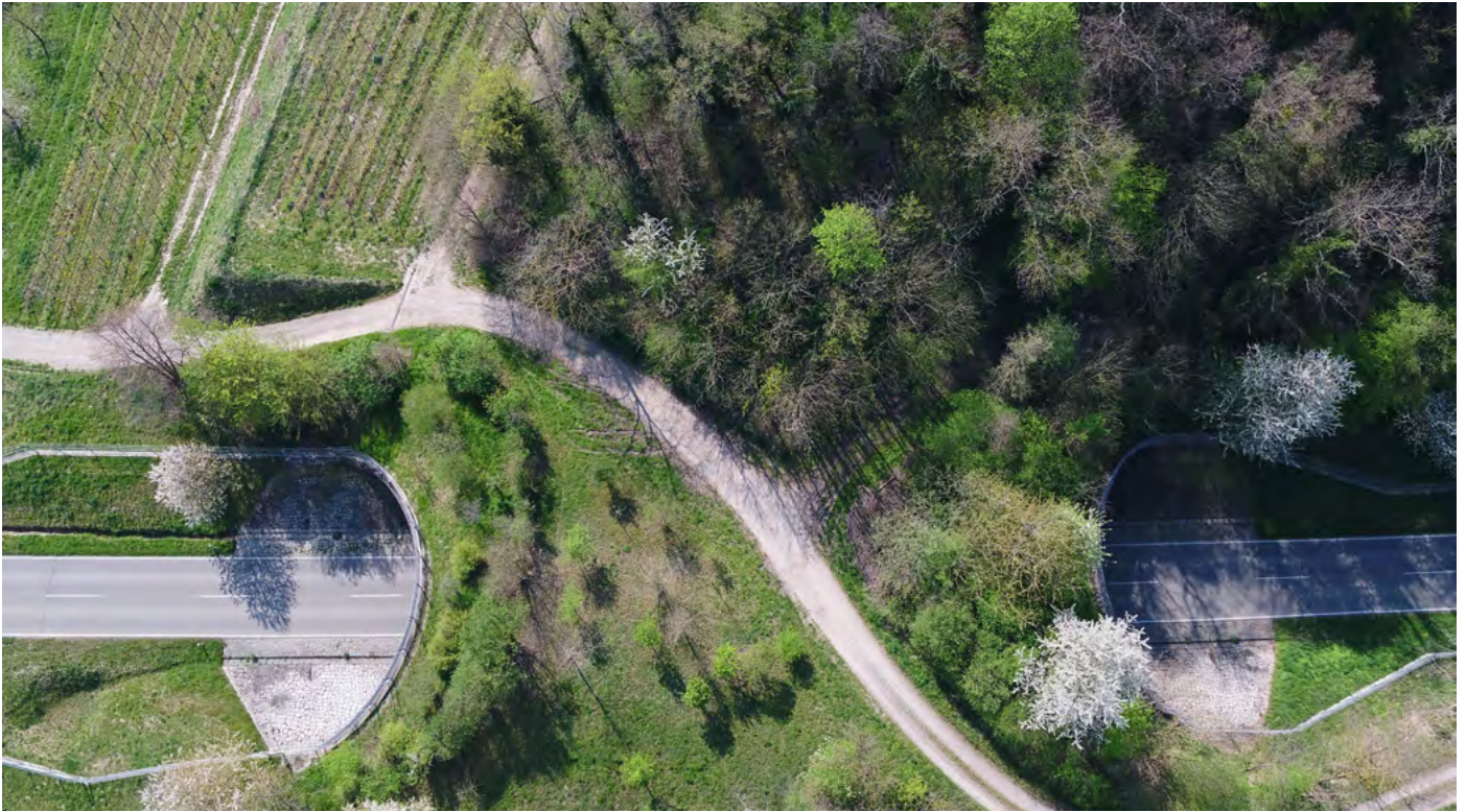
Abbildung 8: Blick auf die Grünbrücke Sasbach von oben. Gut zu erkennen sind die verschiedenen bepflanzten Bereiche mit einer Mischung aus dichten Gehölzstrukturen (rechts), einer Heckenreihe (links) und eine halboffen gehaltene Grünfläche (mittig), die durch den mitüberführten Weg getrennt sind. Datum der Aufnahme: 08.04.2020.
