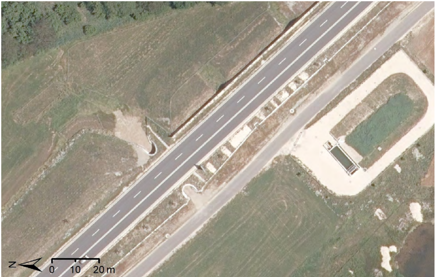
Abbildung 11: Luftbild der Faunaunterführung Überlingen. Auf der Nordost-Seite der Unterführung ist der Andelshofer Weiher mit uferbegleitendem Gehölzsaum (oben links), sowie einer Wiesenfläche zu sehen. Auf der Südwest-Seite des Bauwerks ist der parallel zur Bundesstraße verlaufende Wirtschaftsweg, das dahinterliegende Agrarfeld, ein eingezäuntes Regenrückhaltebecken (mittig rechts) und das angrenzende geschützte Feuchtbiotop (unten rechts) zu erkennen. © Landesamt für Geoinformation und Landentwicklung Baden-Württemberg, www.lgl-bw.de , Az.: 2851.9-1/19.
