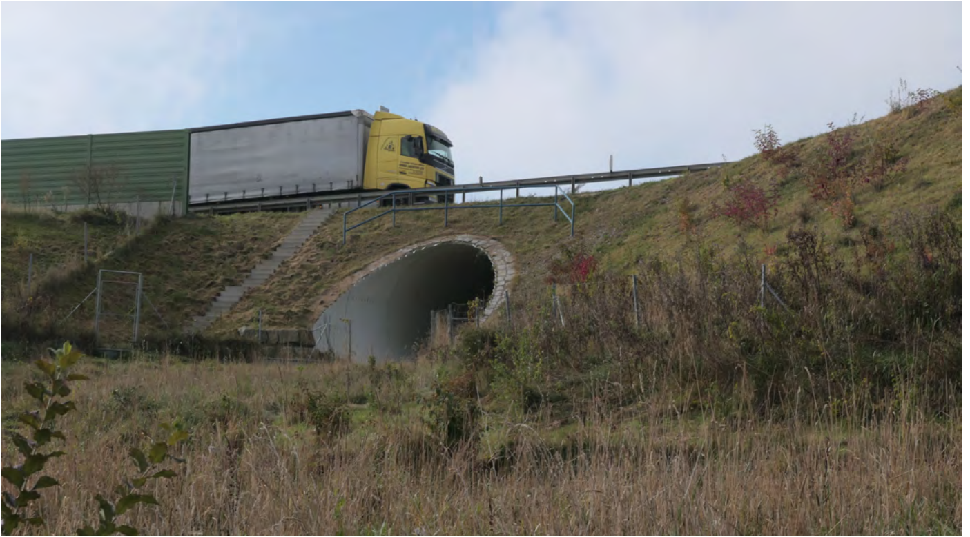
Abbildung 13: Blick auf die Faunaunterführung Überlingen von Osten. Der Zugangsbereich der Nordost-Seite des Bauwerks wird durch extensive Mahd teilweise freigehalten. Hin zur Faunaunterführung verläuft beidseitig ein Wildschutzzaun. In Richtung Süden geht er auf dieser Seite des Bauwerks die Böschung hoch und in eine Lärmschutzwand über. Datum der Aufnahme: 15.10.2021.
