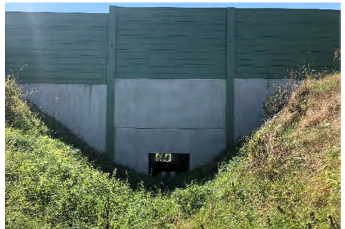
Abbildung 12: Kleintierdurchlass in unmittelbarer Nachbarschaft der Faunaunterführung Überlingen. Die Betonstrukturen vor der Öffnung dienen der Lenkung von Amphibien/Reptilien zum Durchlass. Die Zugangsbereiche werden durch regelmäßige Mahd von Grasüberwuchs freigehalten. Datum der Aufnahmen: 15.10.2021.
