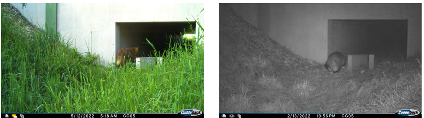
Abbildung 57: Fotofallen-Nachweise von Fuchs und Dachs bei der Nutzung des Kleintierdurchlasses neben der Faunaunterführung Überlingen.
