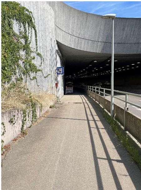
Abbildung 23: Blick auf den Geh- und Radweg in Richtung Plieningen
