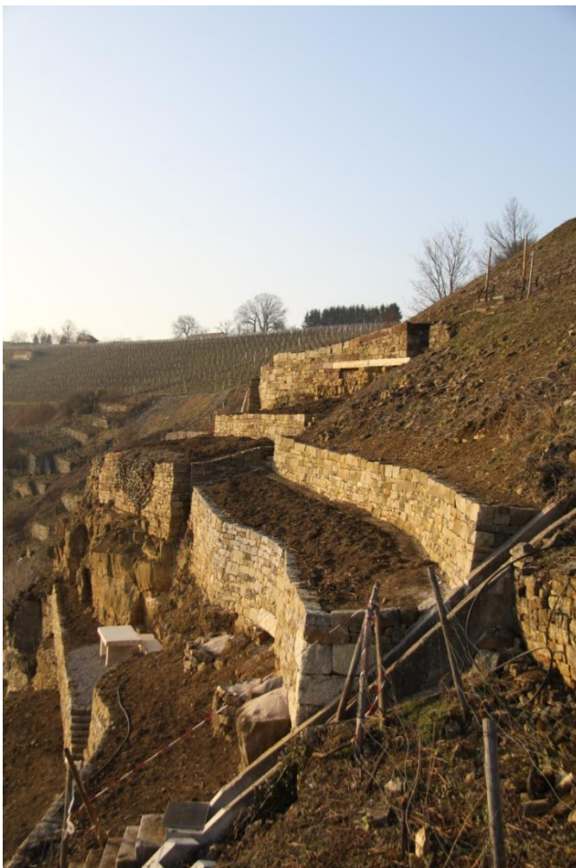
Abb.1: Sanierung von Trockenmauern in einem Weinberg, Gemeinde Illingen
