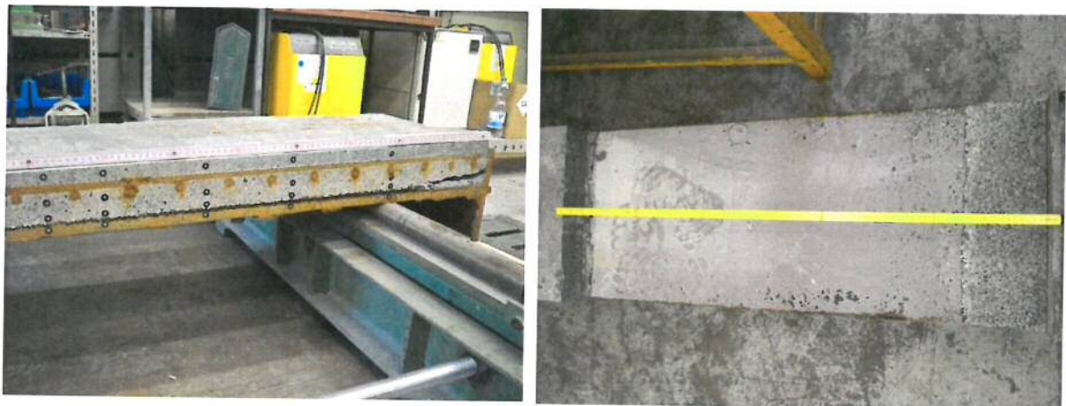
Bild 8 Ansicht der Platte 35 nach dem Versagen infolge der Ablösung der Epoxidharzschicht von der Stahlplatte (links) und Draufsicht auf die Stahlplatte nach Ausführung eines Sägeschnitts durch den Beton in Feldmitte (rechts)
