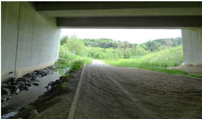
Abbildung 3: Maßnahmentyp Gewässer und Maßnahmentyp Boden – Renaturierung Gewässer und Beseitigung Bodenversiegelung © Foto STZ
