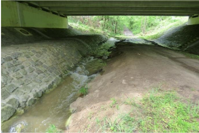
Abbildung 2: Maßnahmentyp Gewässer und Maßnahmentyp Boden – Renaturierung Gewässer und Beseitigung Bodenversiegelung © Foto STZ
