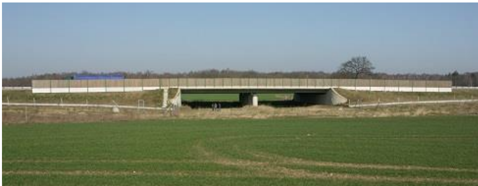
Abbildung 7: Maßnahmentyp Abschirmung Verkehrsträger – Irritationsschutz ©Foto STZ
