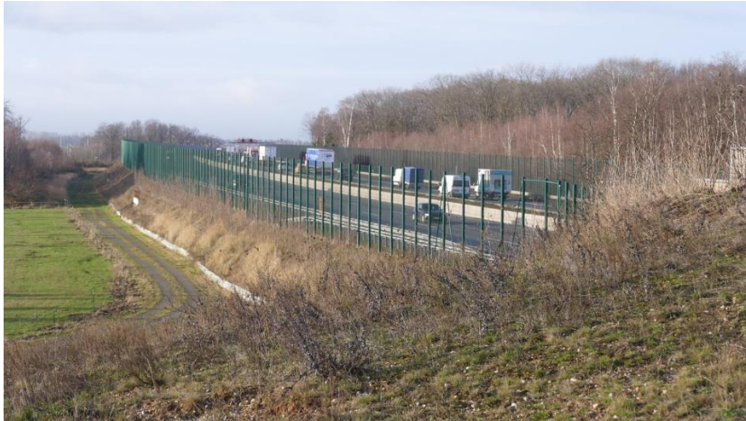
Abbildung 6: Maßnahmentyp Abschirmung Verkehrsträger – Fledermausschutzzaun ©Foto STZ
