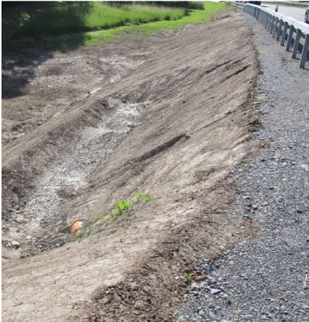
Abb. 1.1: Verteilergraben in Damm
