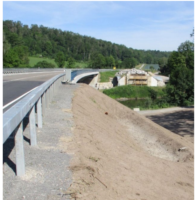
Abb. 1.2: Verteilergraben mit Brücke
